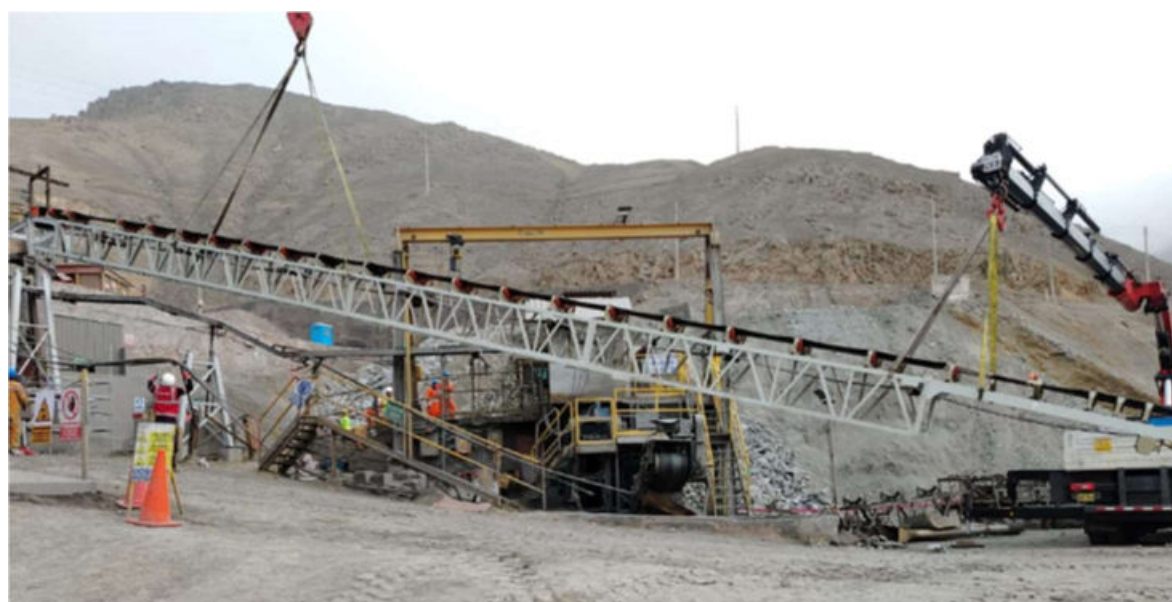
Fabricación y cambio de faja transportadora
