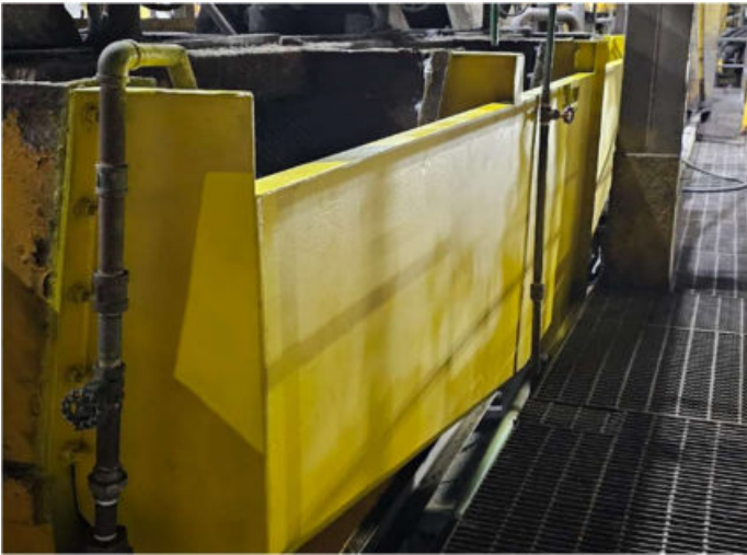
Fabricación de canaletas de celda OK5
