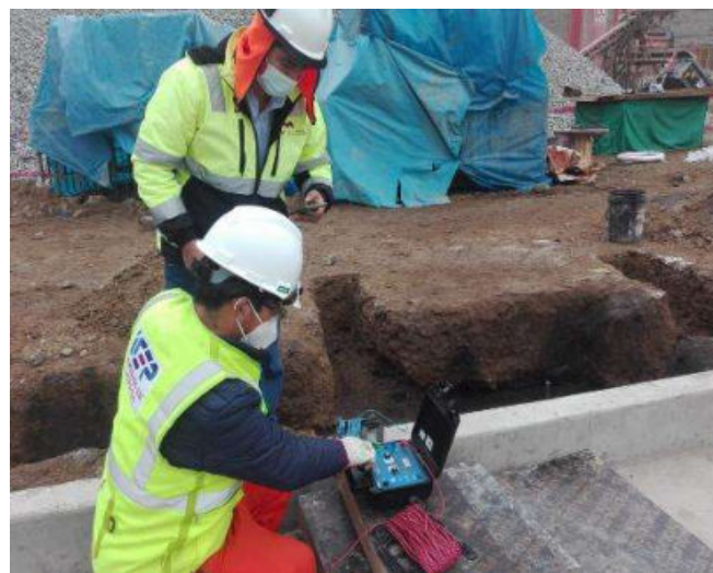
Construcción del SPAT - PRHC
