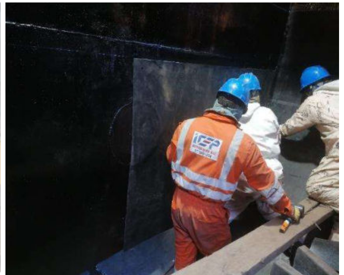
Vulcanizado de celdas y tanques en Lincuna
