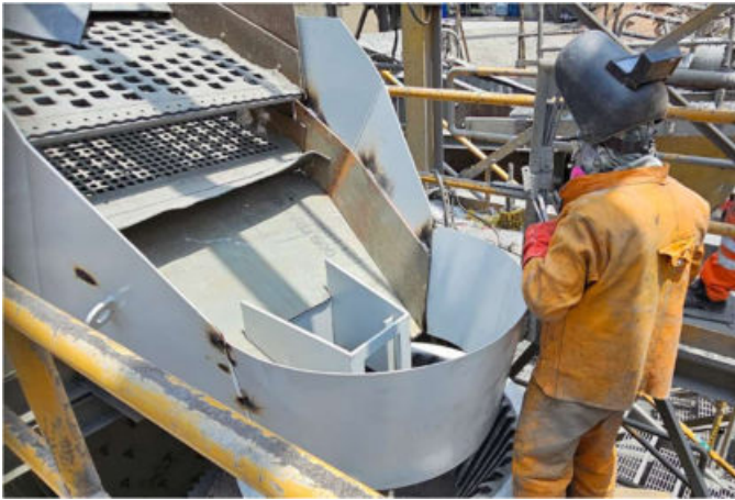
Fabricación y cambio de Chutes
