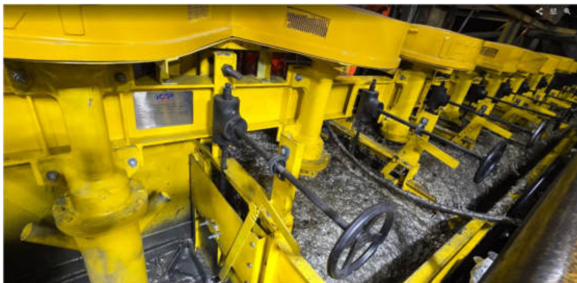
Fabricación y cambio de 08 celdas de flotación Sub A 21 y Sub A 24
