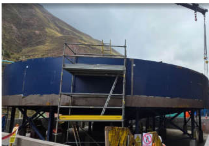
Montaje del espesador de relaves de 20M – Minera Los Quenuales
