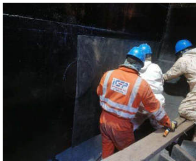
Vulcanizado de celdas y tanques en Lincuna
