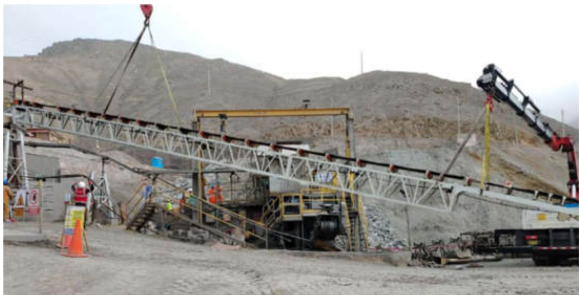
Fabricación y cambio de faja transportadora
