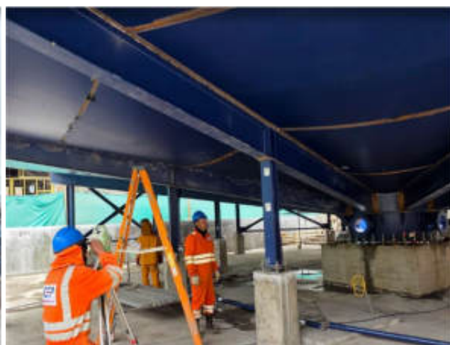
Montaje del espesador de relaves de 20M – Minera Los Quenuales
