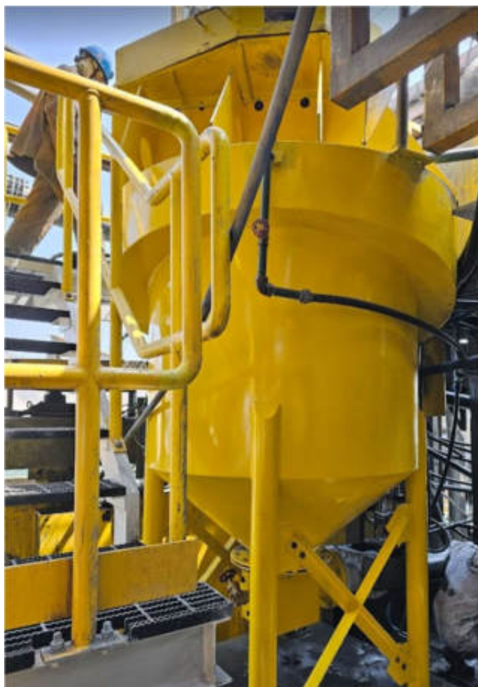
Fabricación de celda ICK 80
