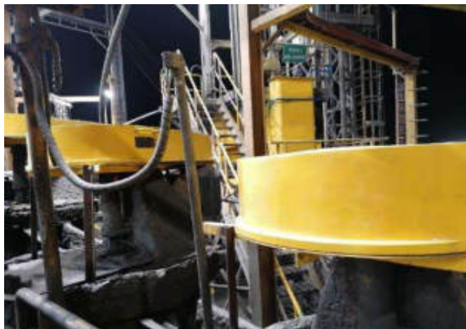
Fabricación de guardas de fibra de vidrio
